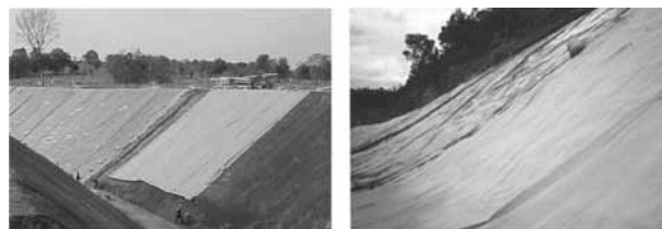
Figura 1: Instalação de GMs em obras de proteção de canais e aterros sanitários 7,8,6
