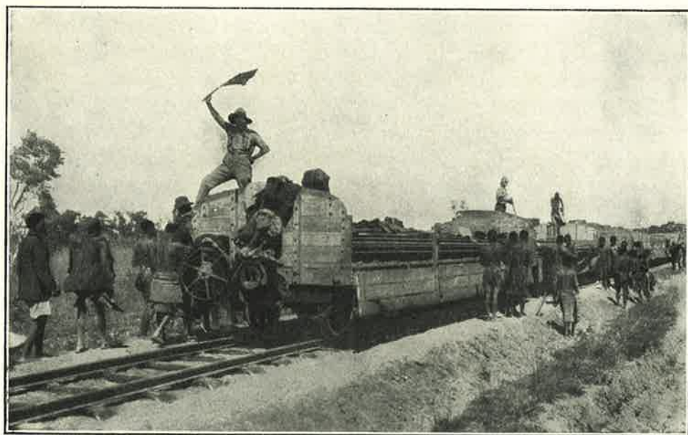
ASSENTAMENTO DE LINHA. COMBOIO DA CONSTRUÇÃO EM MARCHA.
