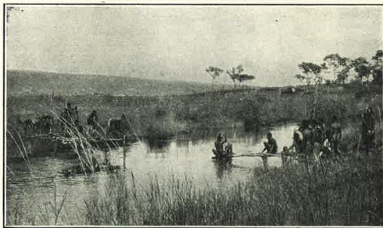
INDIGENAS DE ANGOLA CONSTRUINDO UMA PONTE.
