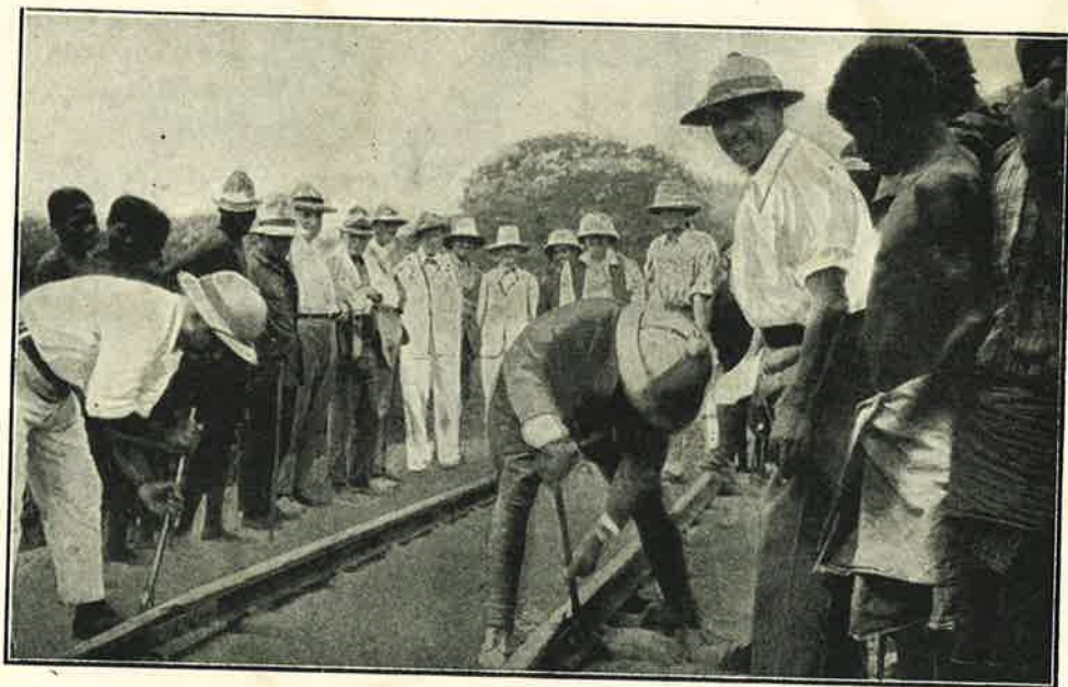
FIXANDO O ULTIMO CARRIL NA FRONTEIRA DE ANGOLA.
