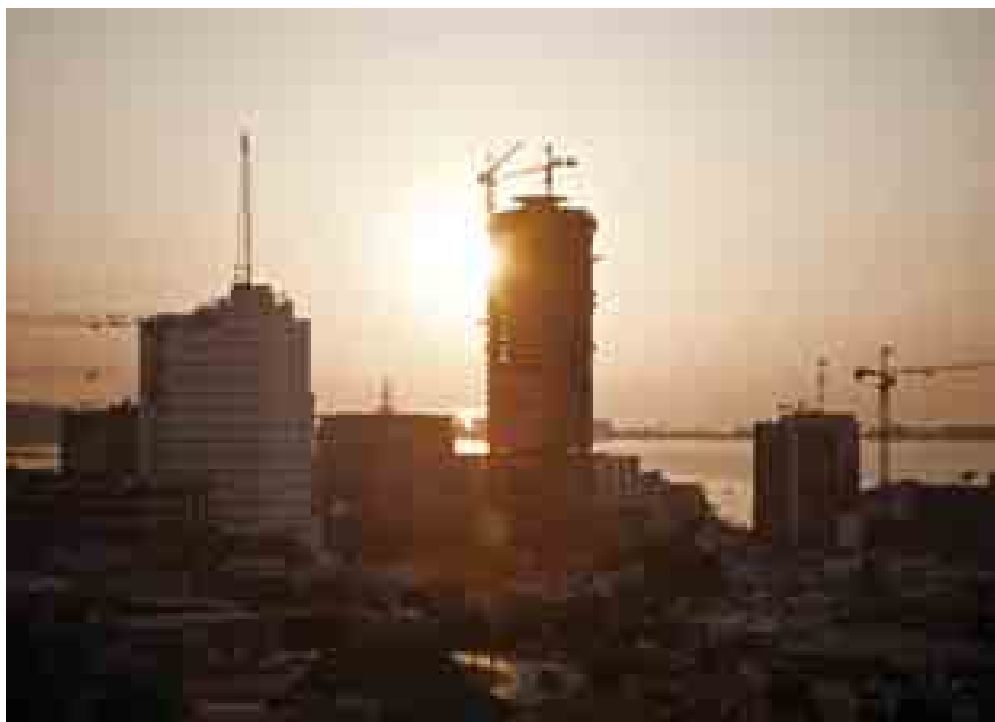
A capital em construção, Luanda
